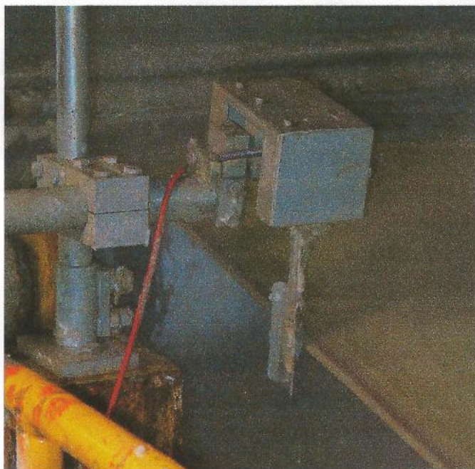
Abb. 1: ElectroPalm im Filz eines Crescentformers mit Changierung zur Vermeidung von Schäden durch Randspritzer
